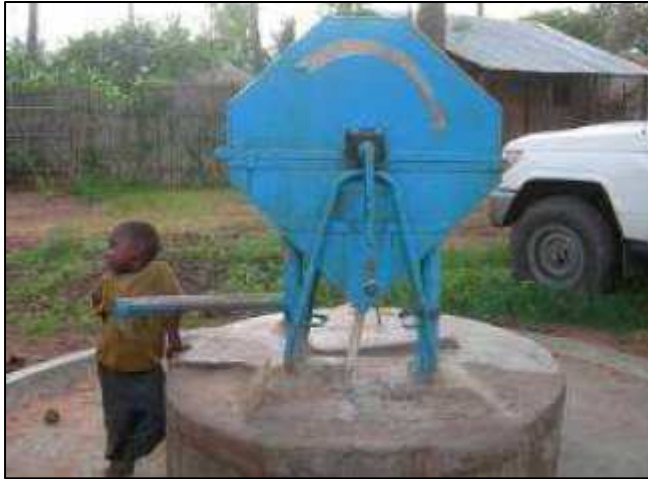
Bomba de corda instalada por el Sr. Firmino en Linde, Cabo Delgado, Mozambique. Fotografía cortesía de Ana Barreiro
