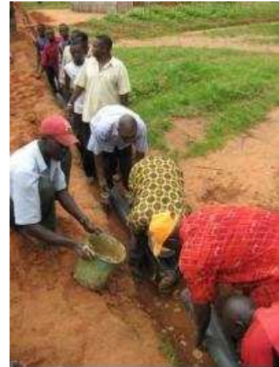
Instalación de tuberías en Mangola
