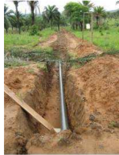
Instalación de tuberías en Mangola
